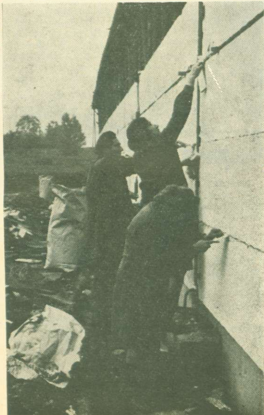
„Obtykacze” przy pracy „na ścianie”
