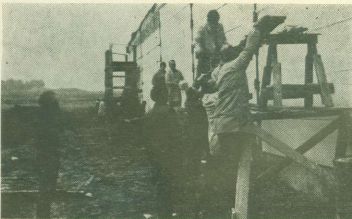
Członkowie partii przy pracy na budowie magazynu OZGraf. Fot. K. PIETRASZYŃSKI
