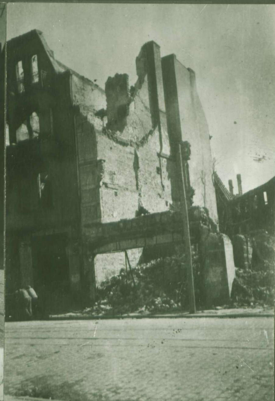
Zniszczone domy naprzeciw drukarni przy ul. 22 lipca
