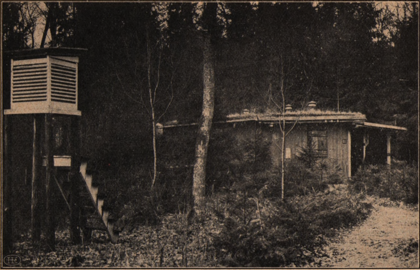
Das aus vollständig eisenfreien Materialien (Beton mit Beimischung von ostpreußischem Braunkohlensand, Holz und Messingschrauben) erbaute Beobachtungshaus der „Erdmagnetischen Basisstation“ in Groß-Raum
