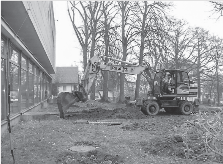
Fot. 1. Pierwszy wykop pod fundament nowej czytelni – początek grudnia 2015 r. Źródło: materiały archiwalne GUMed
