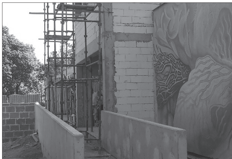
Fot. 3. Nowa klatka schodowa i podjazd przy wejściu głównym – maj, 2016 r. Źródło: materiały archiwalne GUMed
