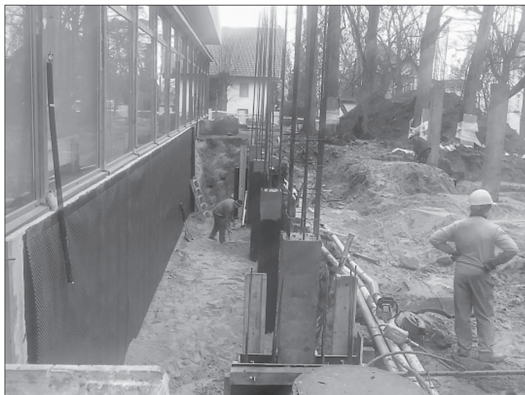
Fot. 2. Słupy konstrukcyjne nowej czytalni – styczeń 2016 r. Źródło: materiały archiwalne GUMed
