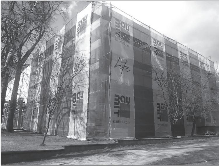
Fot. 4. Ocieplanie budynku – kwiecień, 2016 r. Źródło: materiały archiwalne GUMed
