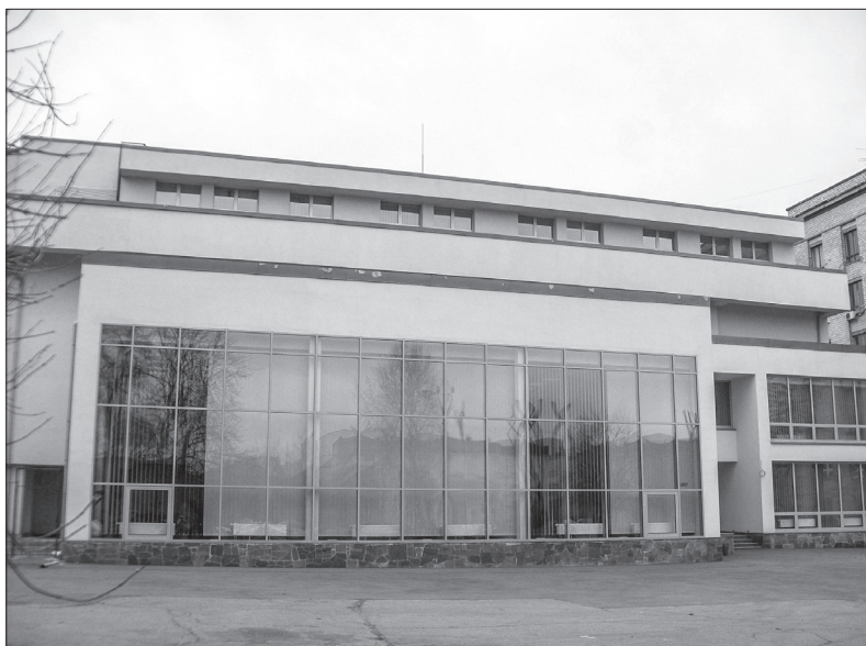
Fot. 3. Państwowa Naukowa Biblioteka Architektoniczno-Budowlana im. W. Zabolotnego: a) przed renowacją
