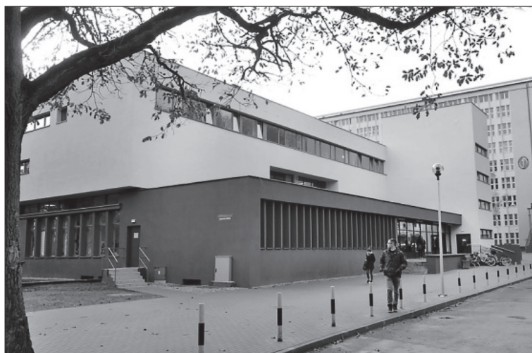
Fot. 24. Elewacja biblioteki od strony ul. Dębinki Źródło: materiały archiwalne GUMed
