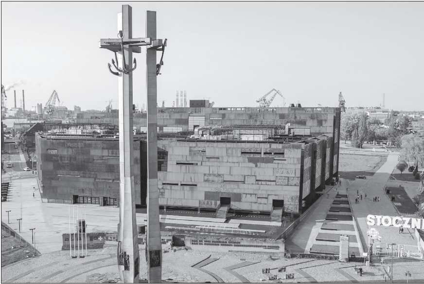
Fot. 1. Europejskie Centrum Solidarności – widok z zewnątrz (aut. zdj. G. Mehring, Archiwum ECS)
