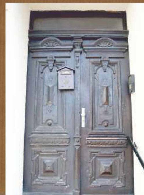
Analogiczne drzwi przy ulicy Żeromskiego 5.
