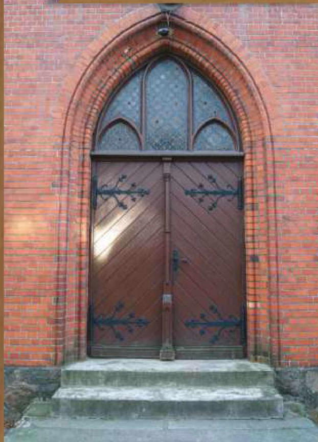
Powyżej główne drzwi wejściowe, poniżej drzwi do kaplicy południowej.
